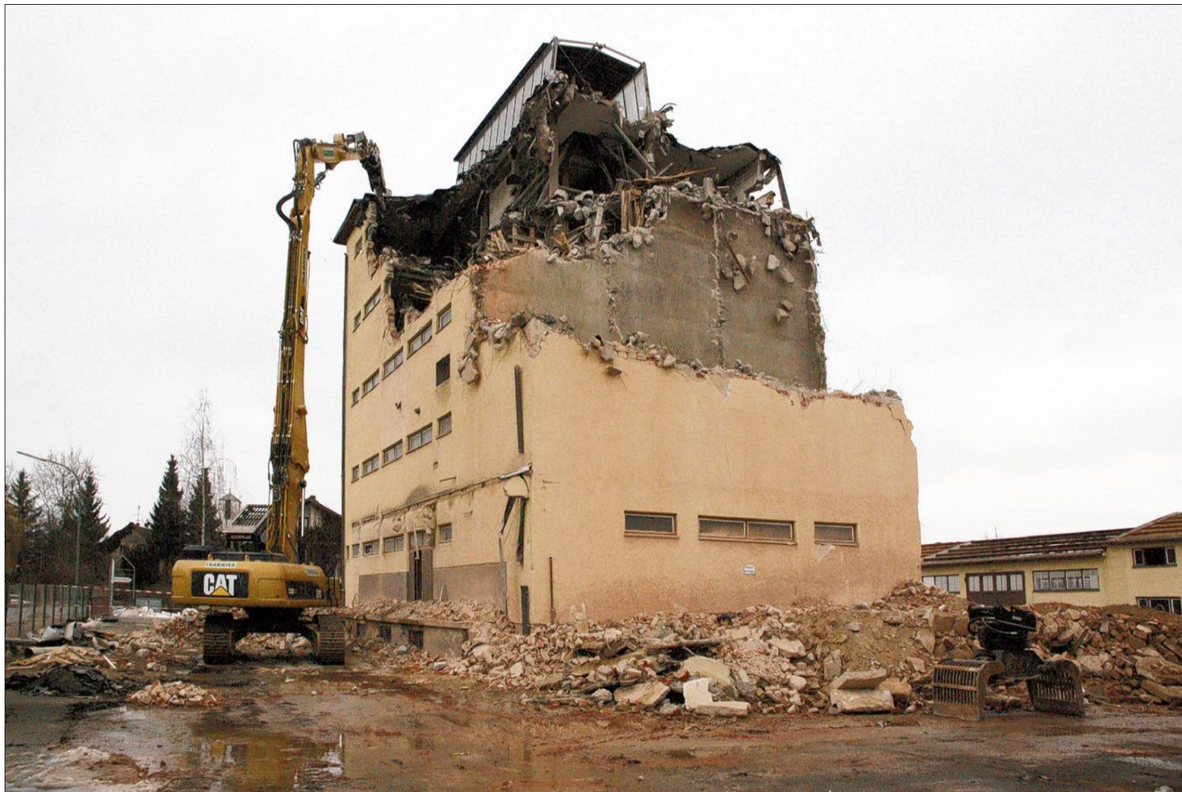
DAS EHEMALIGE BAYWA-GEBÄUDE an der Herrfeldener Straße wird derzeit abgerissen. Abriss-Spezialisten der Firma Isarkies trennen die dabei anfallenden Baustoffe entsprechend der aktuellen Vorschriften. Auf dem Grundstück plant die Balk-Gruppe Vilsbiburg den Bau eines Seniorenzentrums mit Pflegeeinrichtung und Betreutem Wohnen. Die Pläne für das Projekt liegen derzeit am Landratsamt zur Genehmigung. (Foto: Katharina Schmid)
